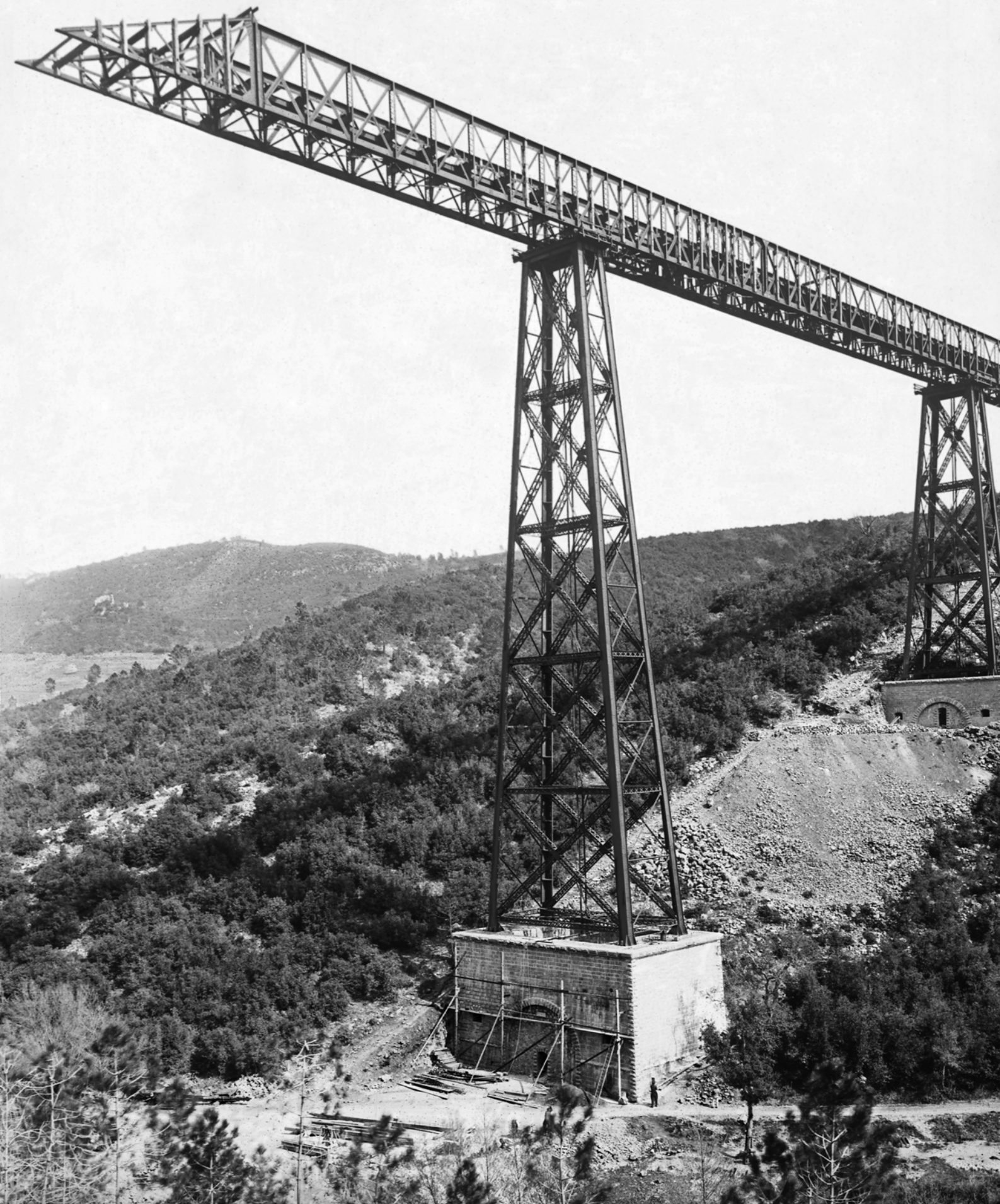
14.2 Construction du pont métallique ferroviaire sur la Siagne (ligne Nice-Draguignan), 1890. AD06 60Fi 1635
