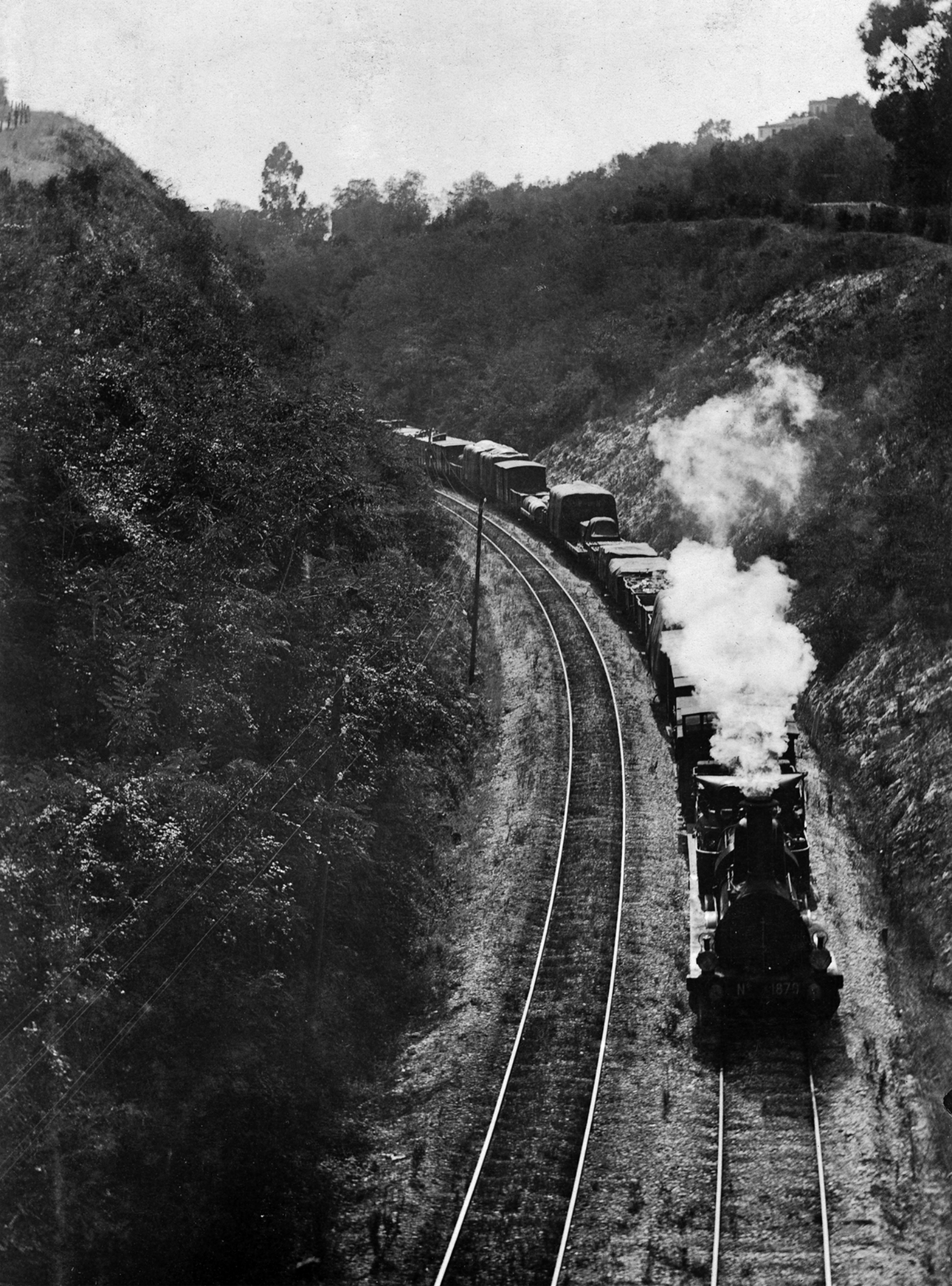
14.4 Arrivée d'un train à Nice. AD06 10Fi 4406
