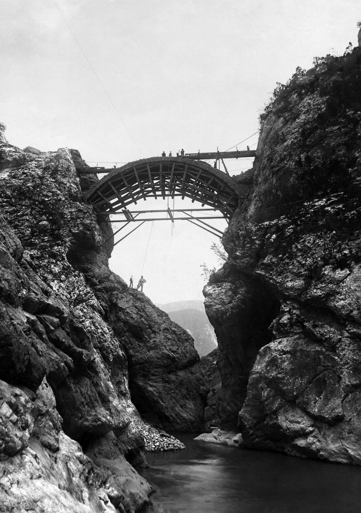
14.6 Pont routier en construction sur la clue de l'Estéron, 1899. AD06 10Fi 982
