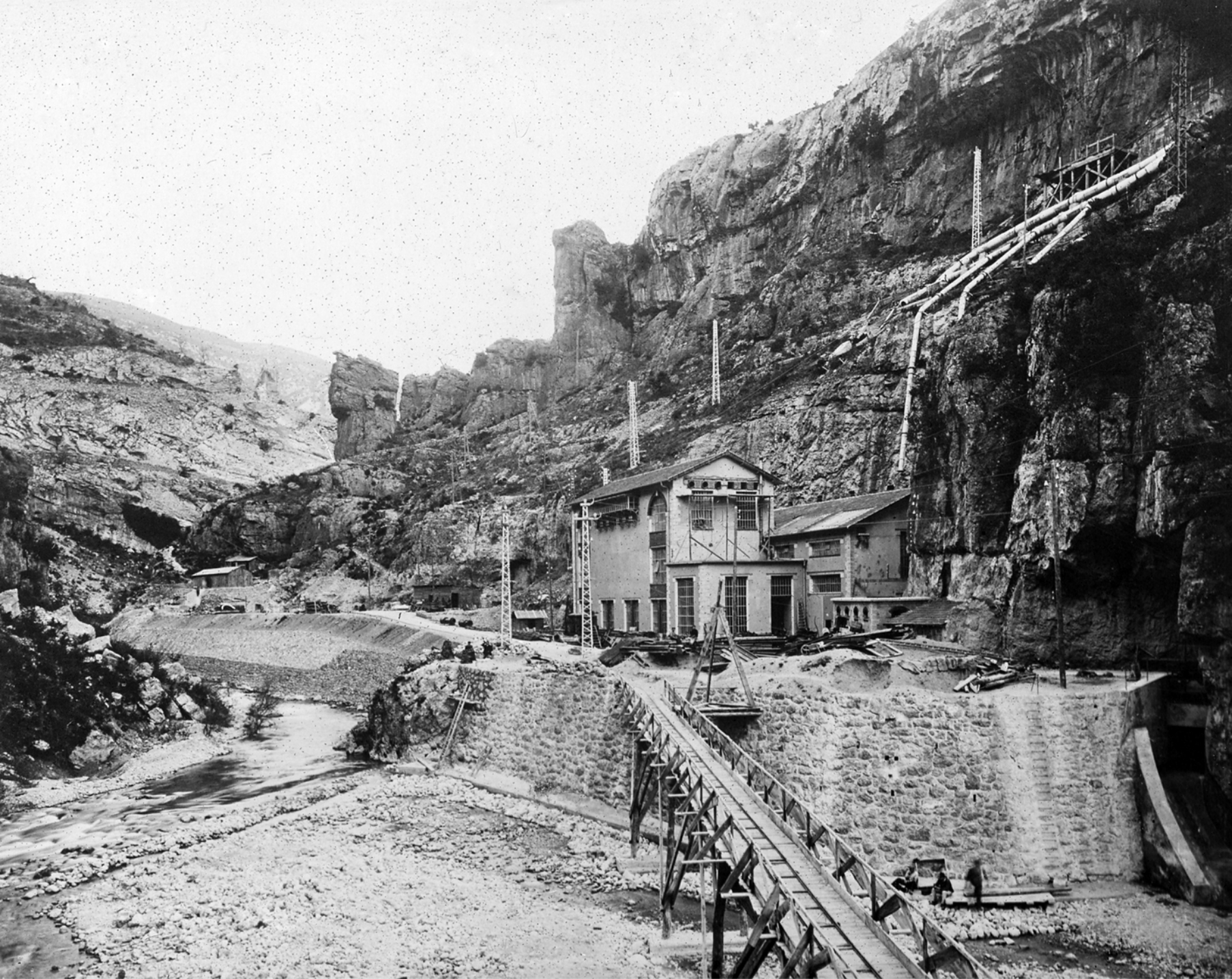
18.1 Usine hydroélectrique de Saint-Cézaire, sur la Siagne. AD06 60Fi 1556
