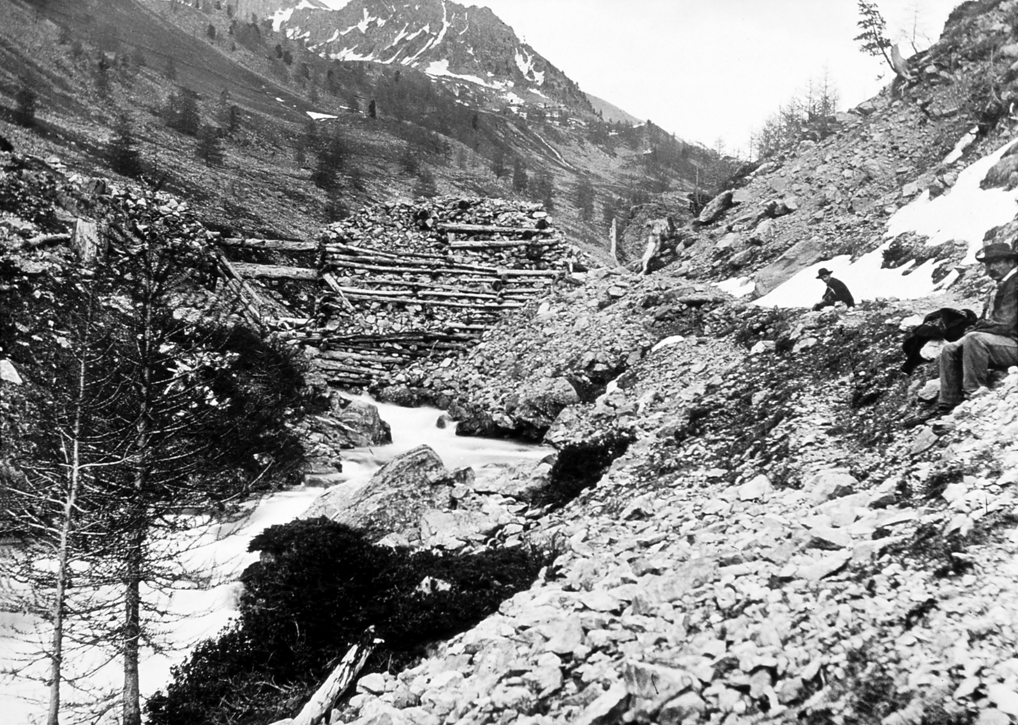
16.4 Barrage de rondins et cailloux destiné à l'évacuation des bois dans le vallon de Chastillon, 23 mai 1899. photographie Victor de Cessole
