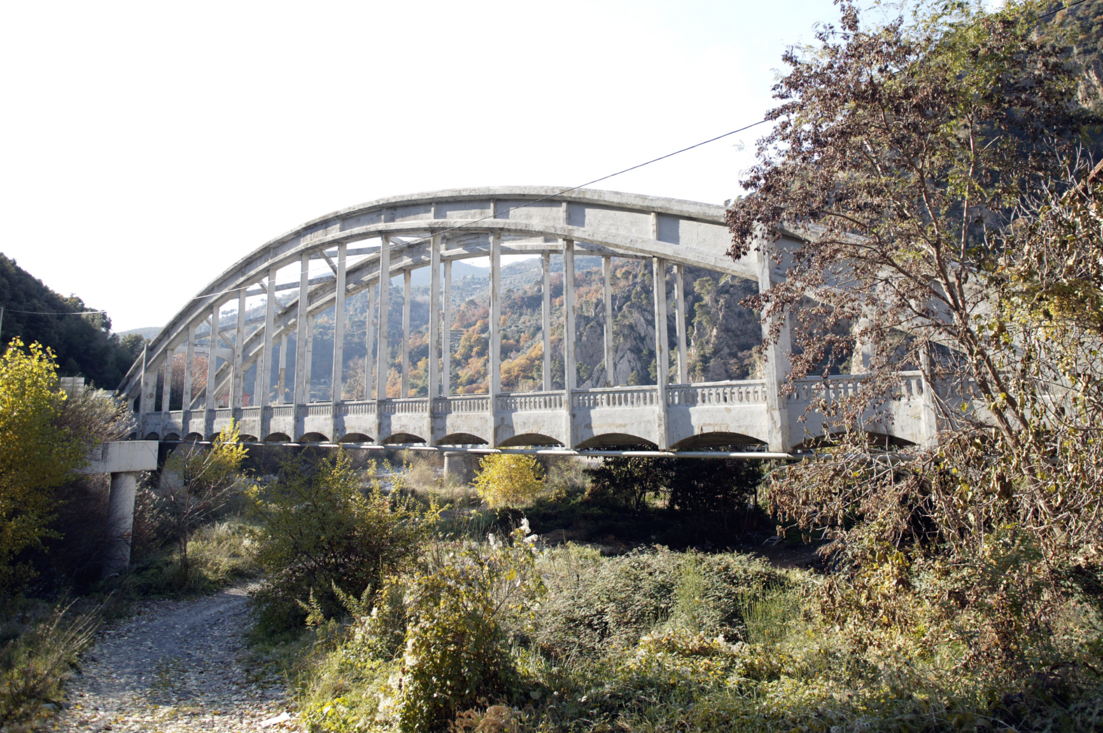
19.6 Pont Durandy en béton armé construit sur la Vésubie en 1921. AD06, photographie Jean-François Boué
