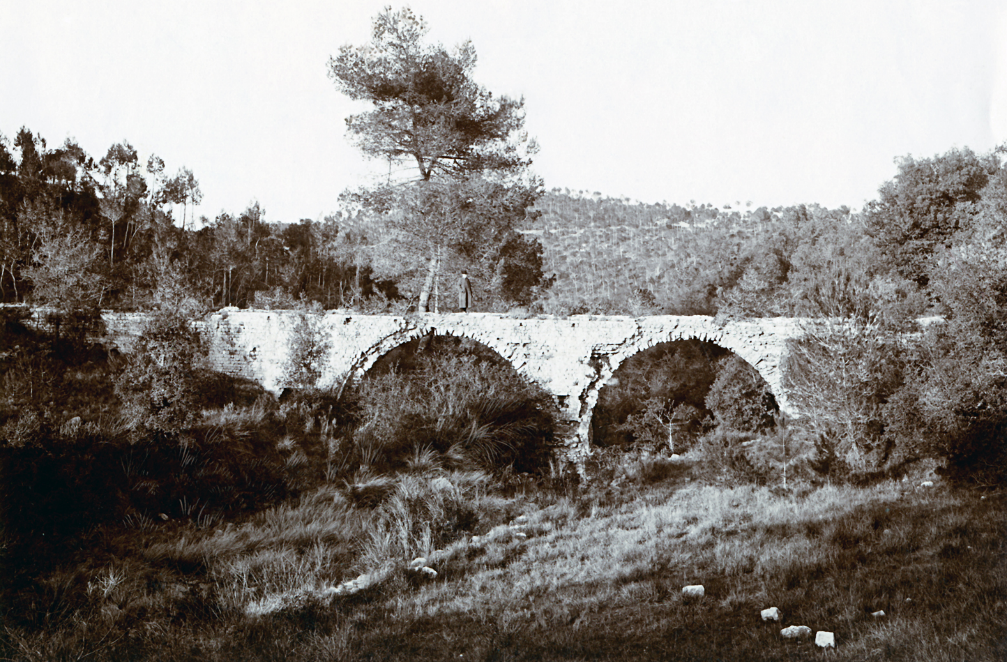
3.4 Vestiges de l'aqueduc romain des Clausonnes (Antibes), s.d., vers 1900. AD06, 4T 11
