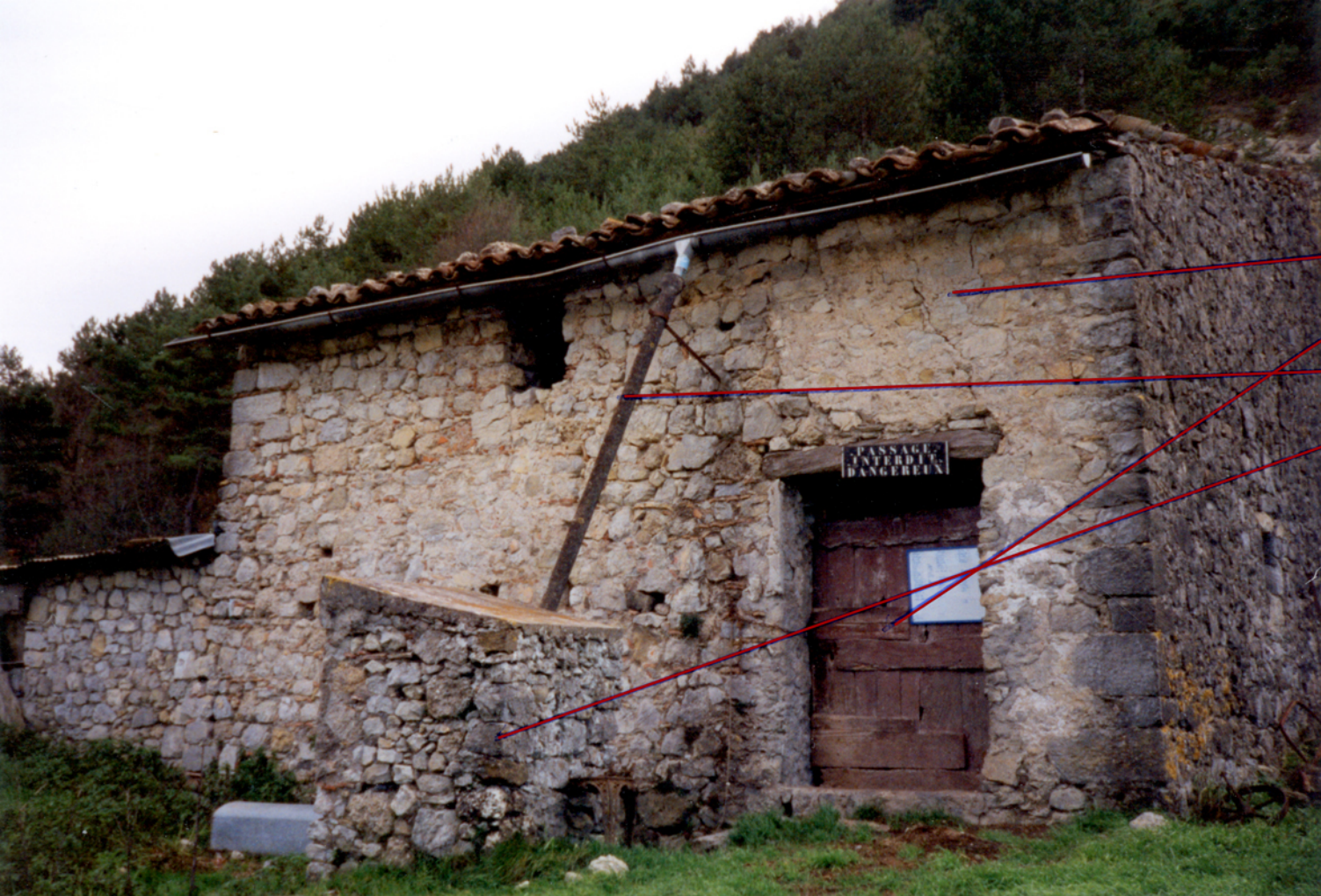
3.7 Récupération d'eau de pluie sur le toit d'une bergerie
