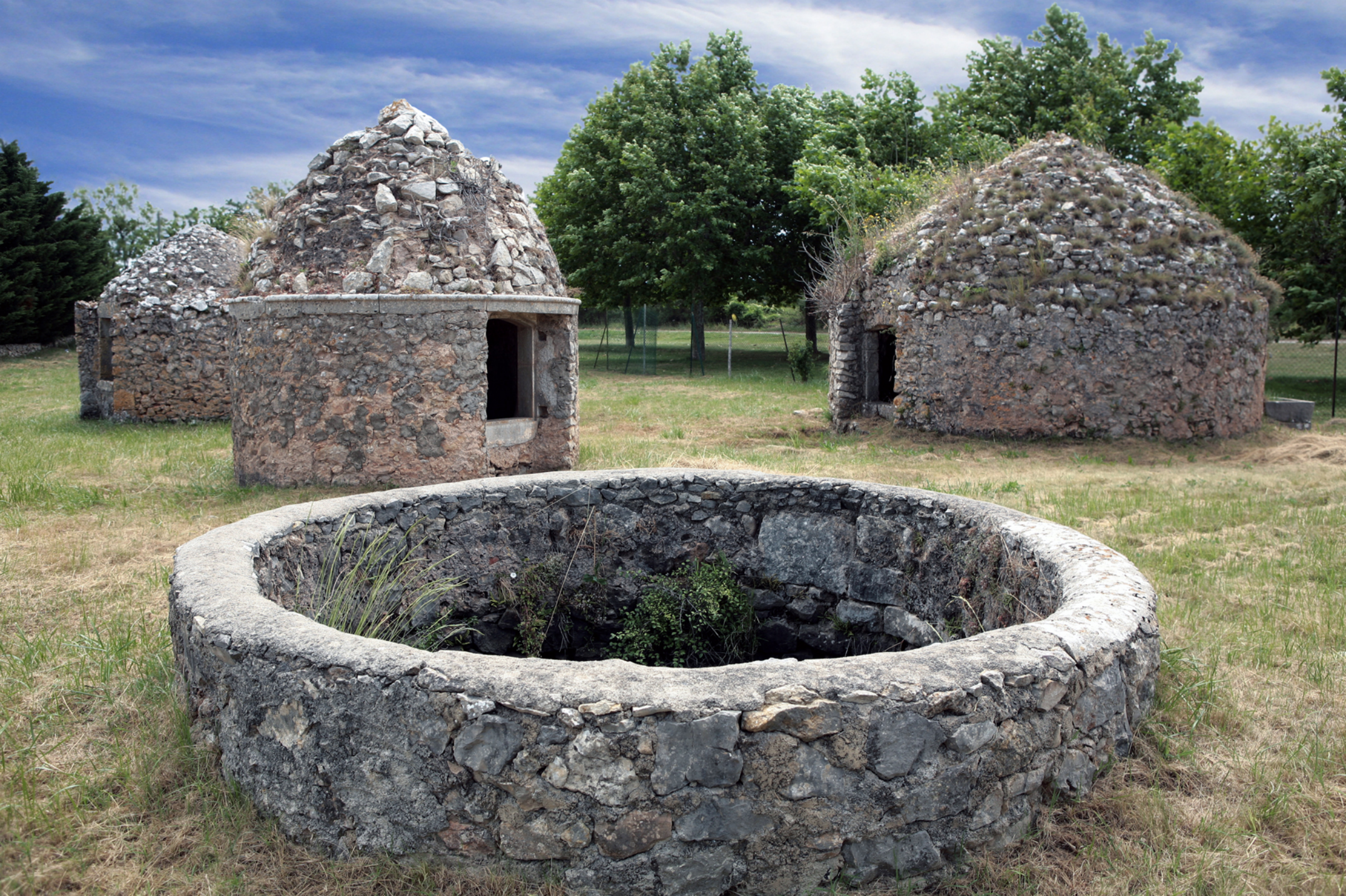
3.8 Puits à Saint-Cézaire. AD06, photographie Jean-François Boué
