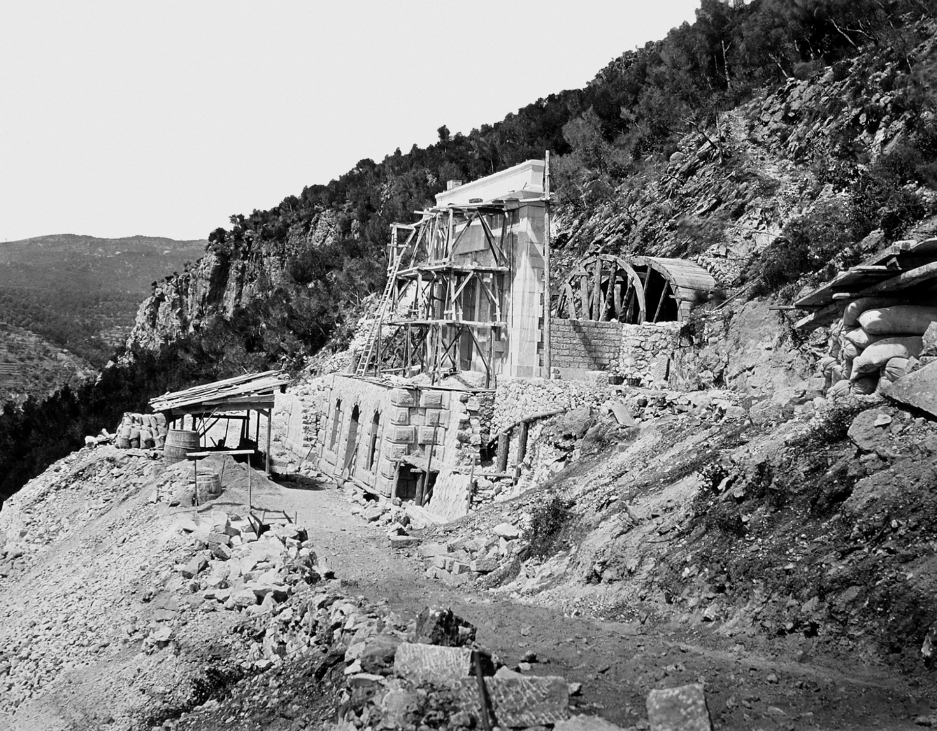
5.7 Construction de la chambre d'arrivée des sources de Sainte-Thèle, vers 1867. © Bibliothèque de Cessole
