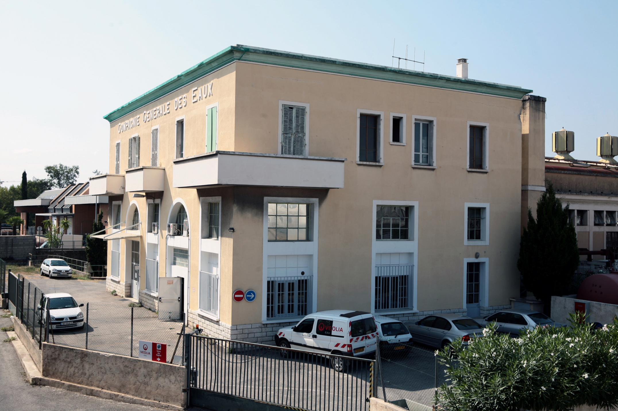
6.5 Usine de pompage des Sagnes à Nice. AD06, photographie Jean-François Boué
