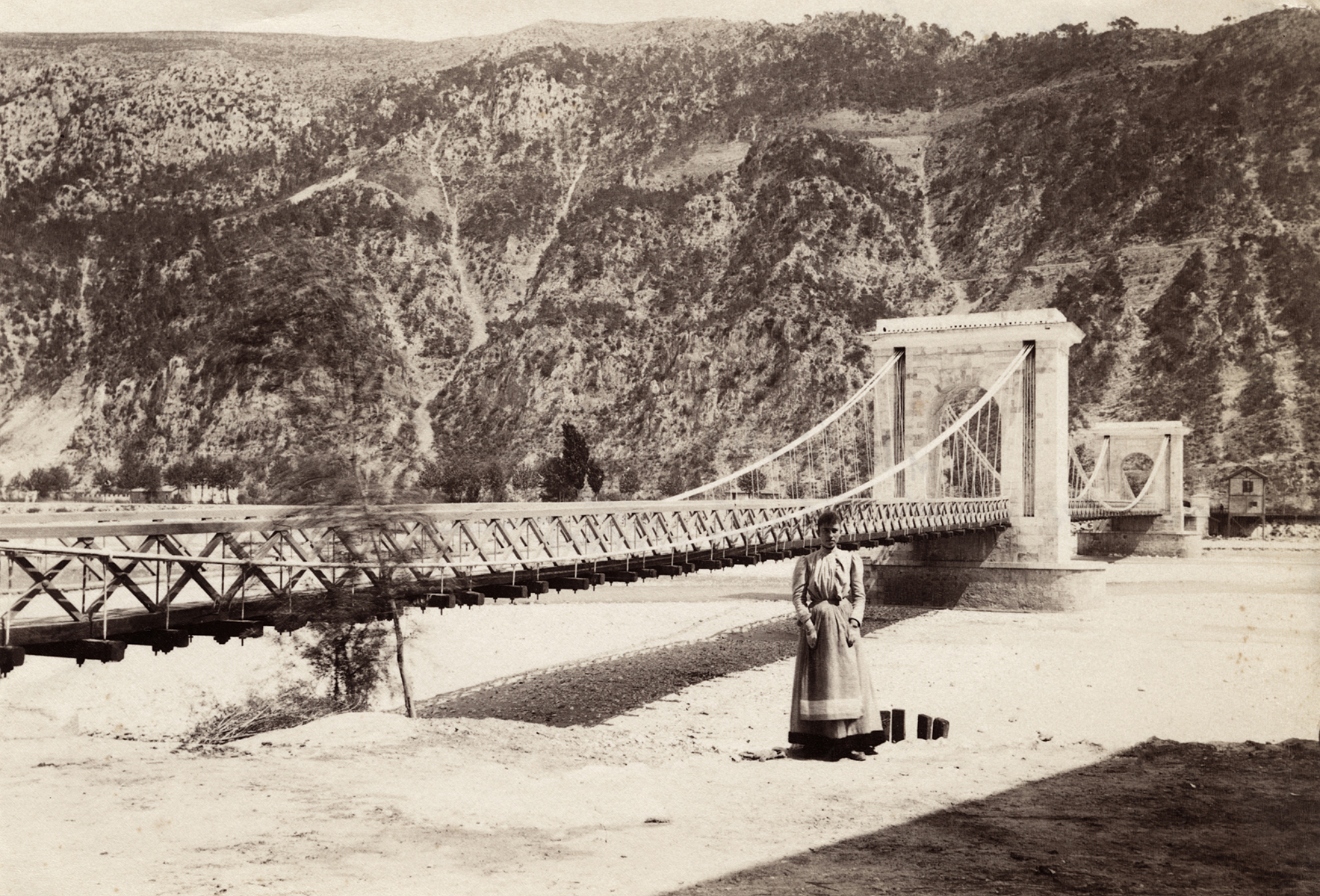
18.5 Pont suspendu Charles-Albert sur le Var. AD06, 10Fi 2863
