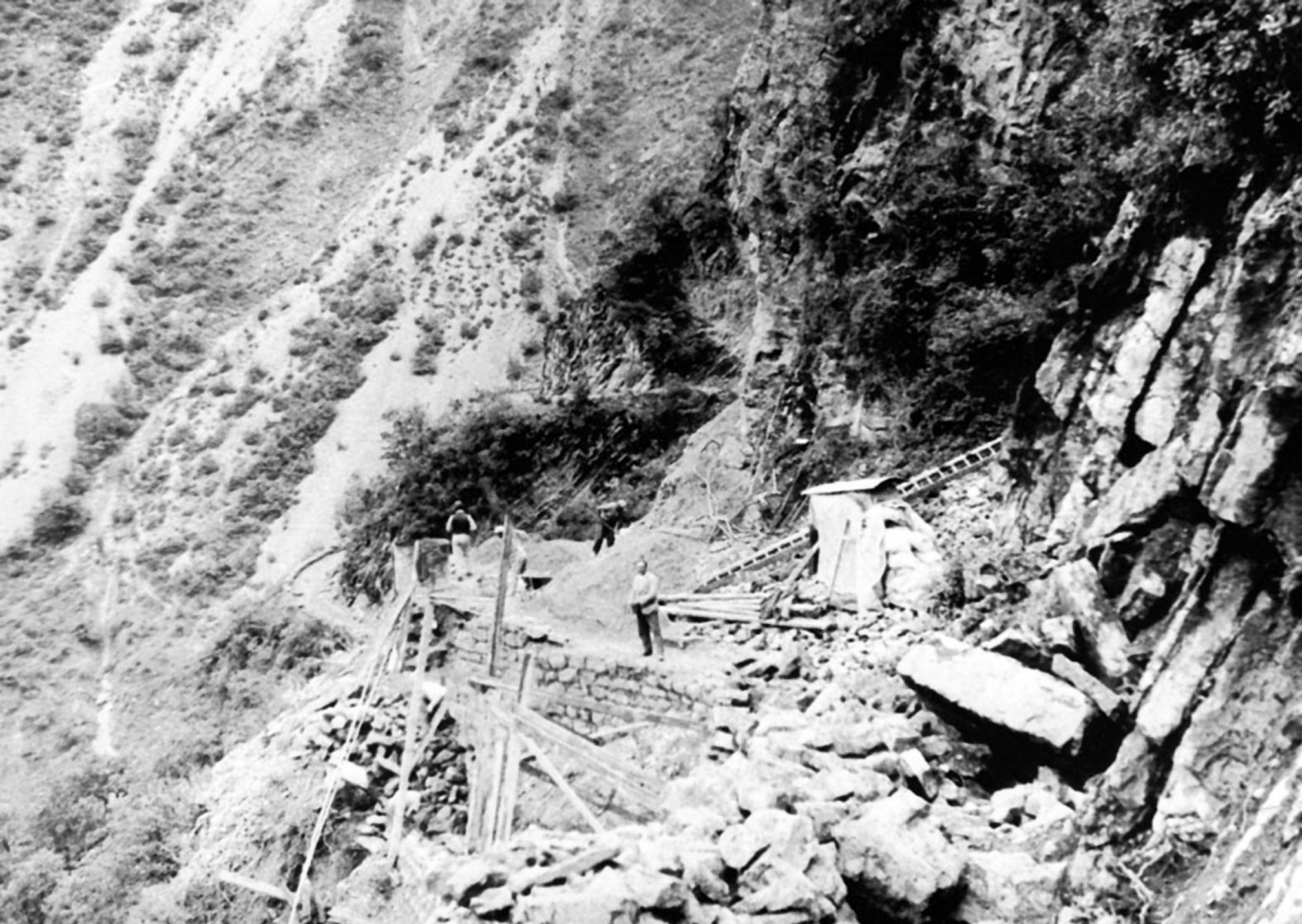
5.1 Construction d'une route de montagne, gorges du Cians, années 1930. Arch. dép. Alpes-Maritimes (fonds Detragiache), 90 J 1, tous droits réservés.
