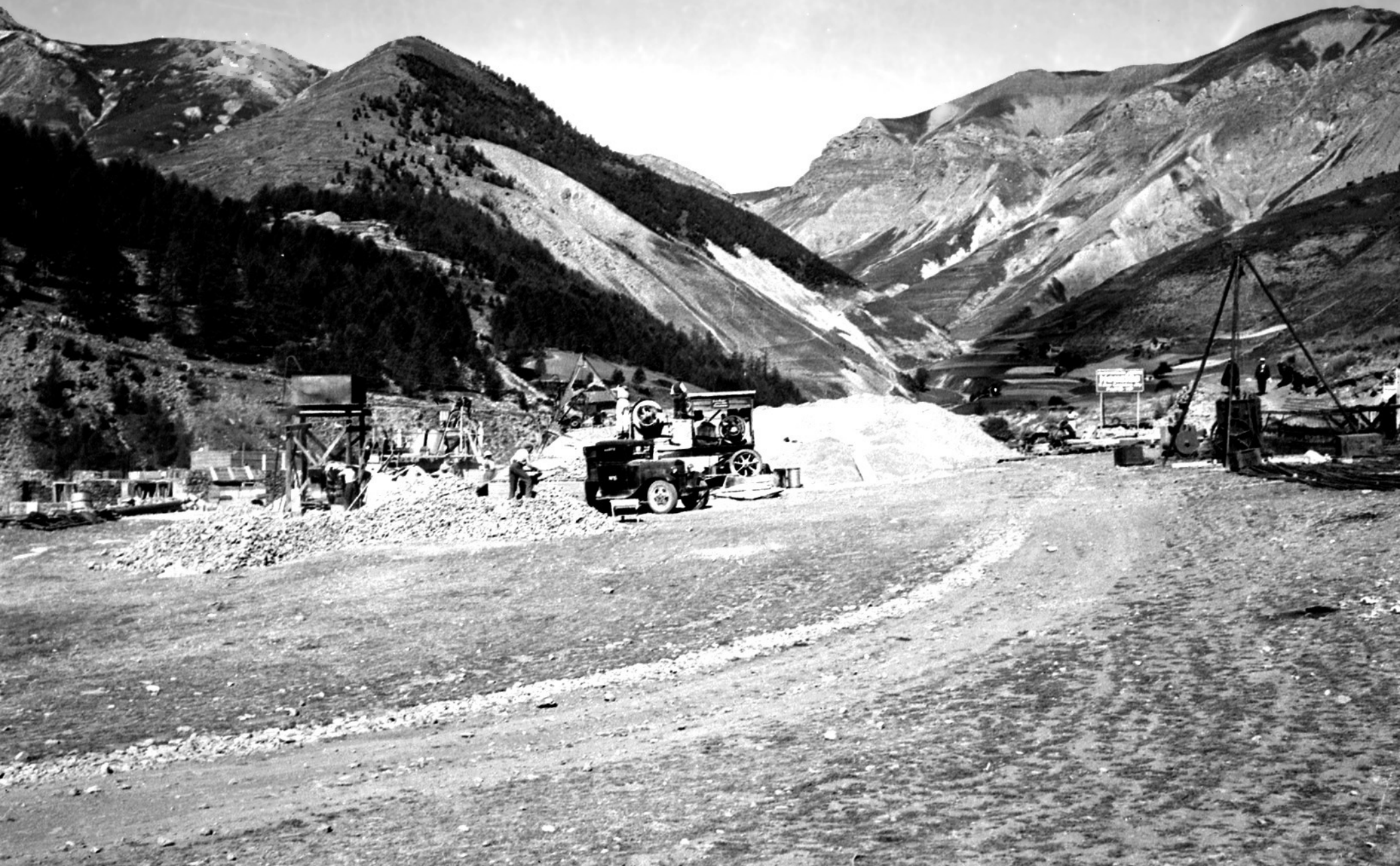
7.2 Travaux de construction du téléphérique de Las Donnas, Auron, juillet 1936. Arch. dép. Alpes-Maritimes (photographie Camus), 23 Fi 1669.
