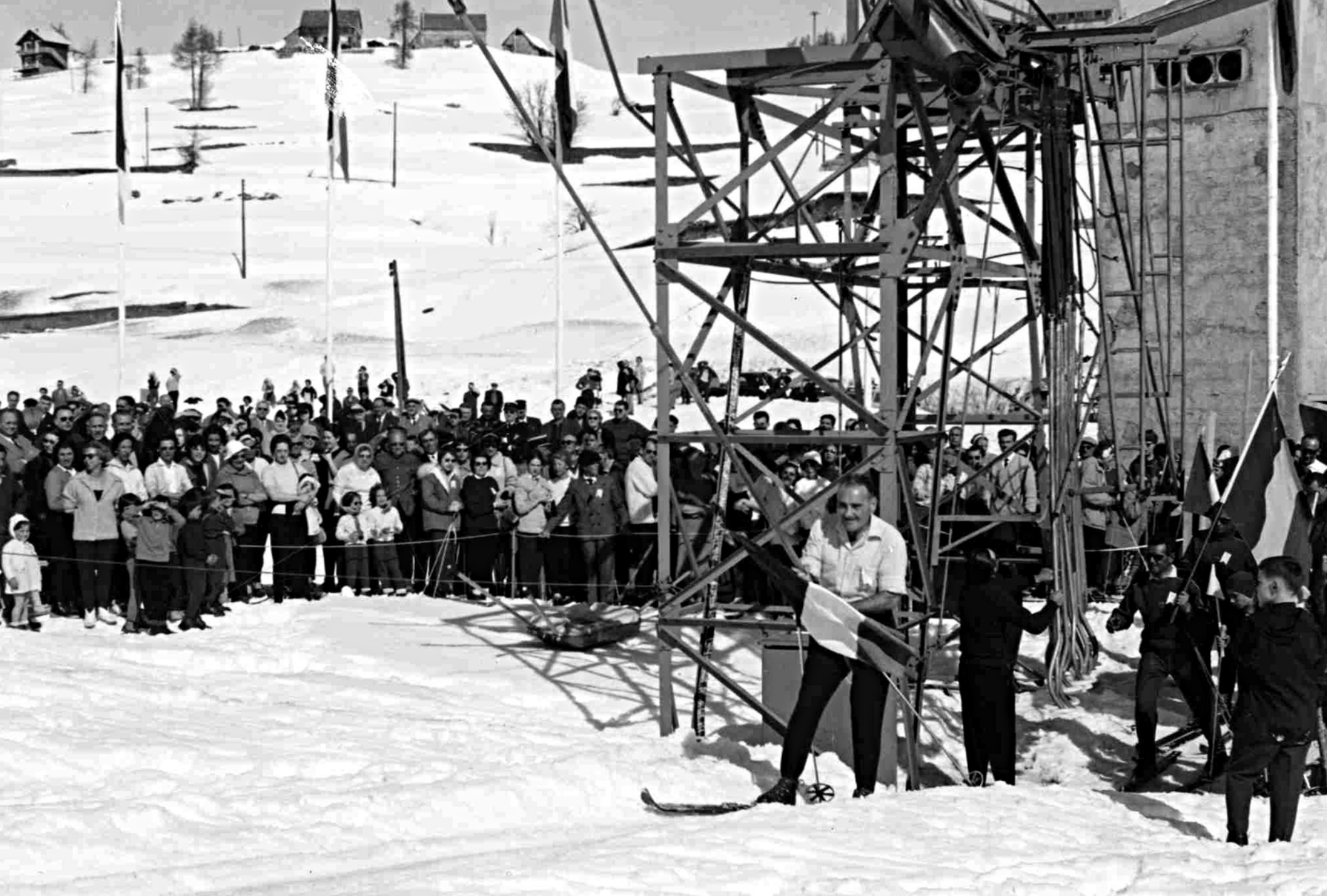
9.6 Inauguration du remonte-pente par le préfet Pierre-Jean Moatti, Valberg, 1960. Arch. dép. Alpes-Maritimes (photographie Pierre Guillemard), fonds Pierre-Jean Moatti, 176 J 3, tous droits réservés.
