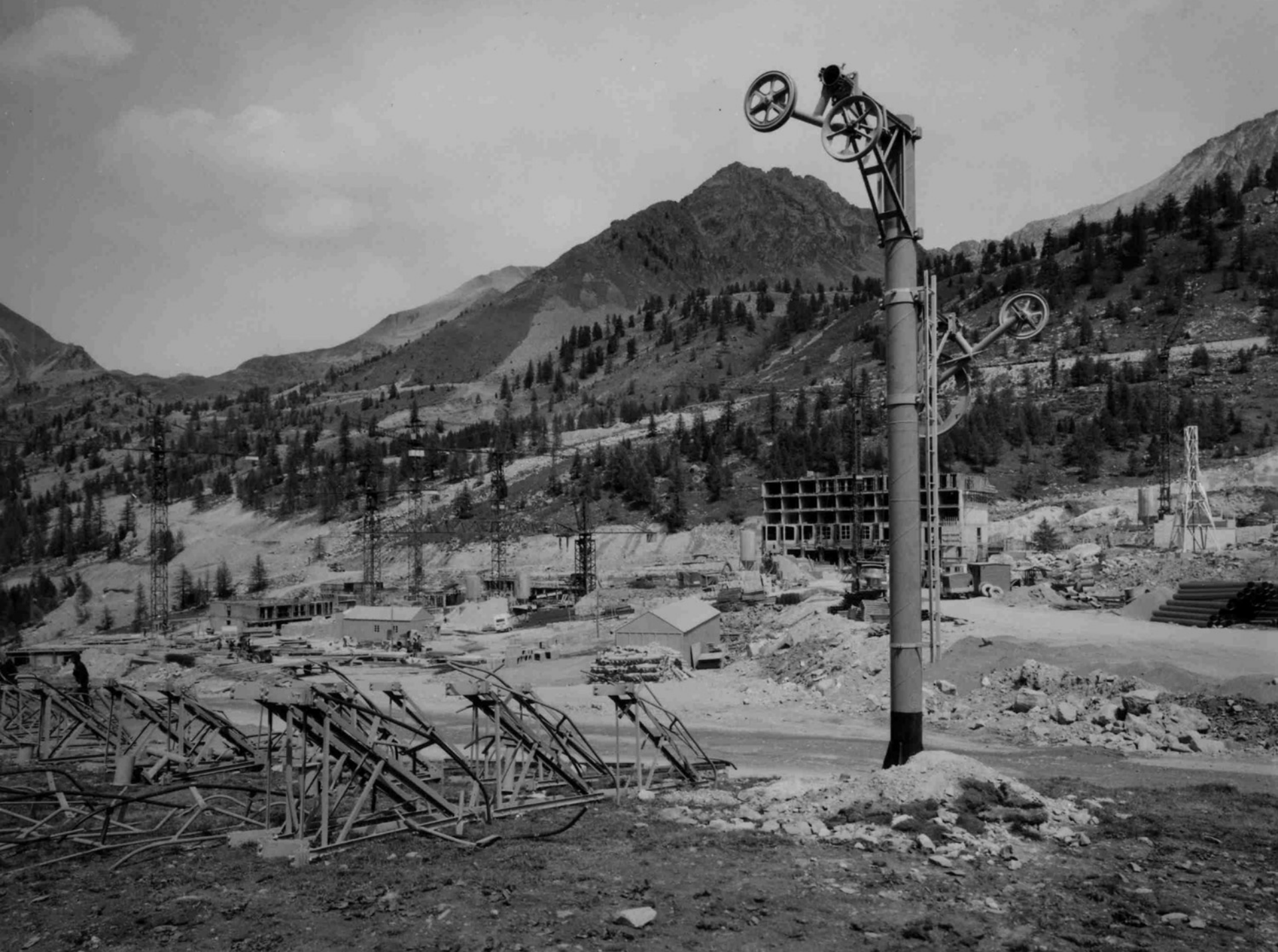
9.16 Chantier de construction de la station de sports d'hiver d'Isola 2000, 1971. Arch. dép. Alpes-Maritimes, 598 W 127.
