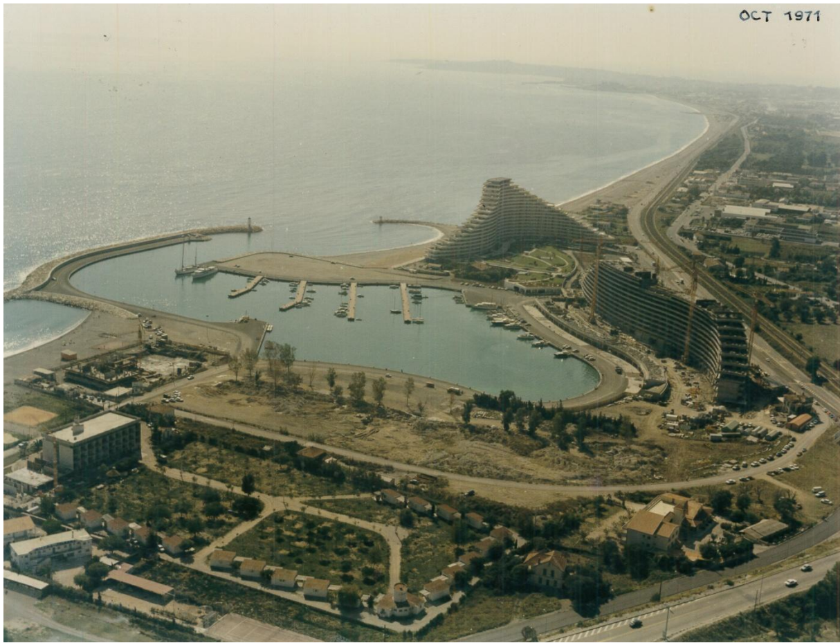
Fig. 11. La construction du port. Photo de A. M. Baconnet, Cannes. Collection Groupe MARINA. Arch. mun. Villeneuve-Loubet, 16 Num 005.
