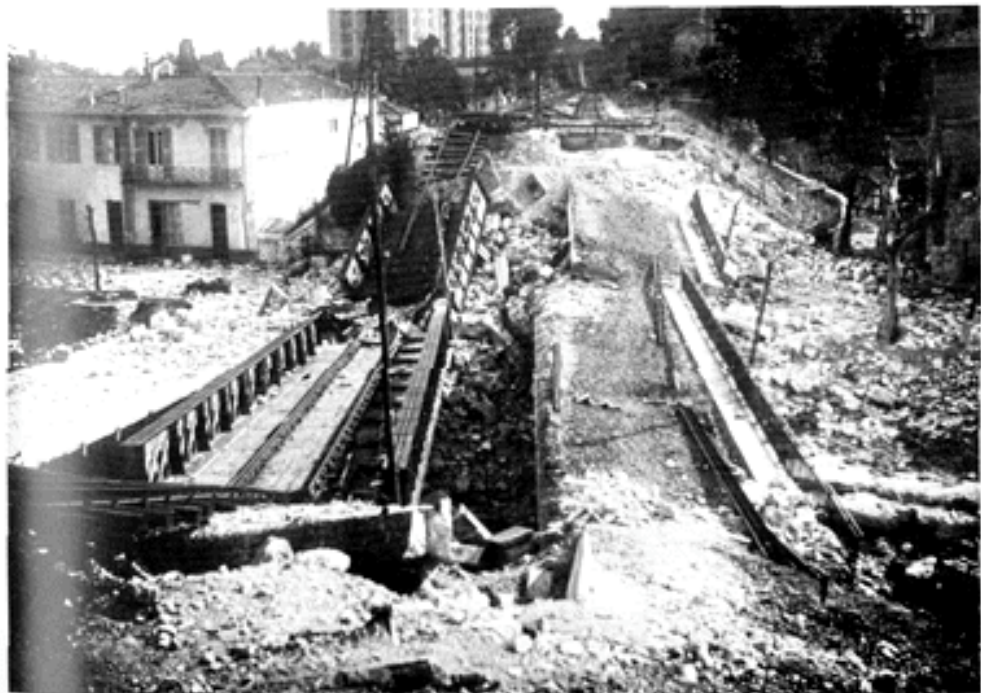
Les viaducs du Borrigo effondrés après leur destruction par le Génie français (Photo 1 re Armée italienne)
