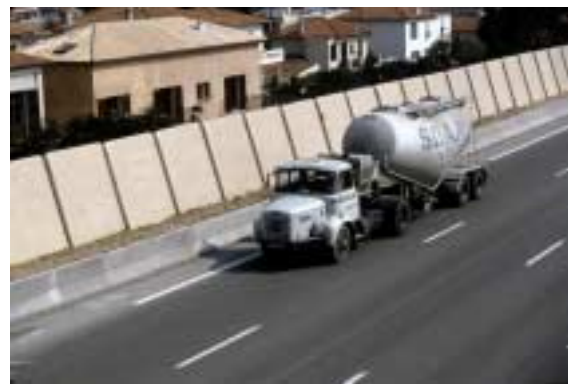
Mur anti-bruit au bord de l'autoroute à Saint-Laurent-du-Var
