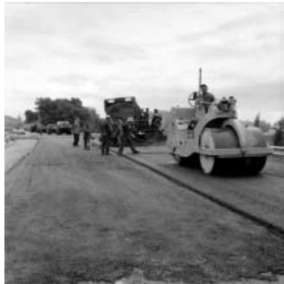
Pose de Bitume à Mandelieu, 1963
