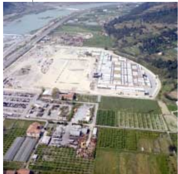
Centre commercial Lingostière en construction dans la plaine agricole du Var, 1978
