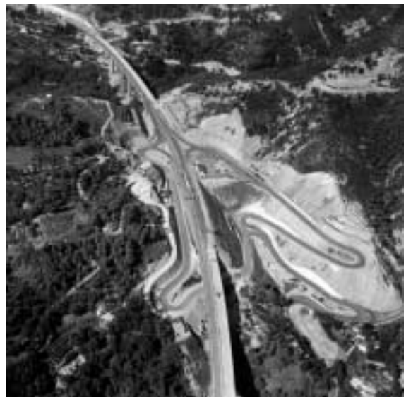
Travaux d'échangeur de Menton, 1969
