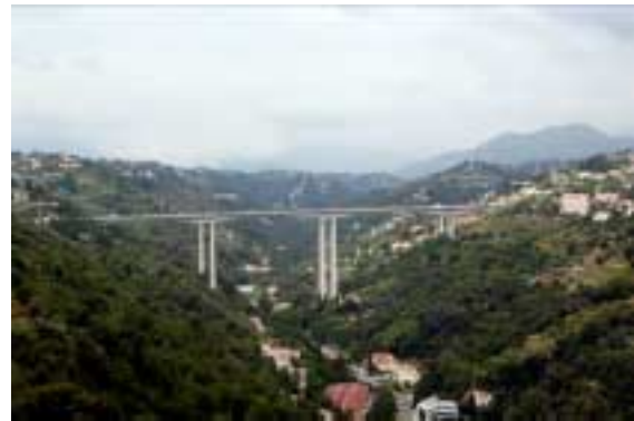
Viaduc autoroutier de Magnan, 2008
