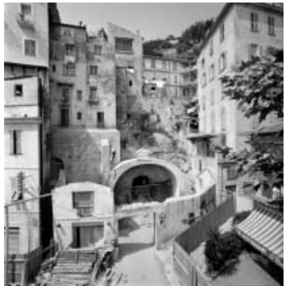
Percement du tunnel de Menton, 1963
