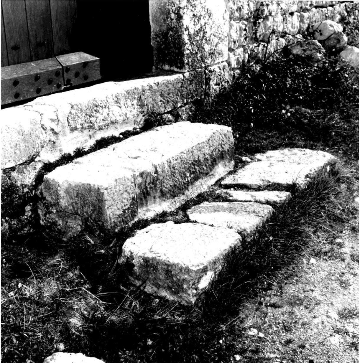
Fig. 75. La façade antérieure, la porte principale, détail : marches d'accès (la seconde marche est constituée du pied de l'ancienne table d'autel, la cavité destinée aux reliques est visible à gauche), vues depuis le sud-ouest
