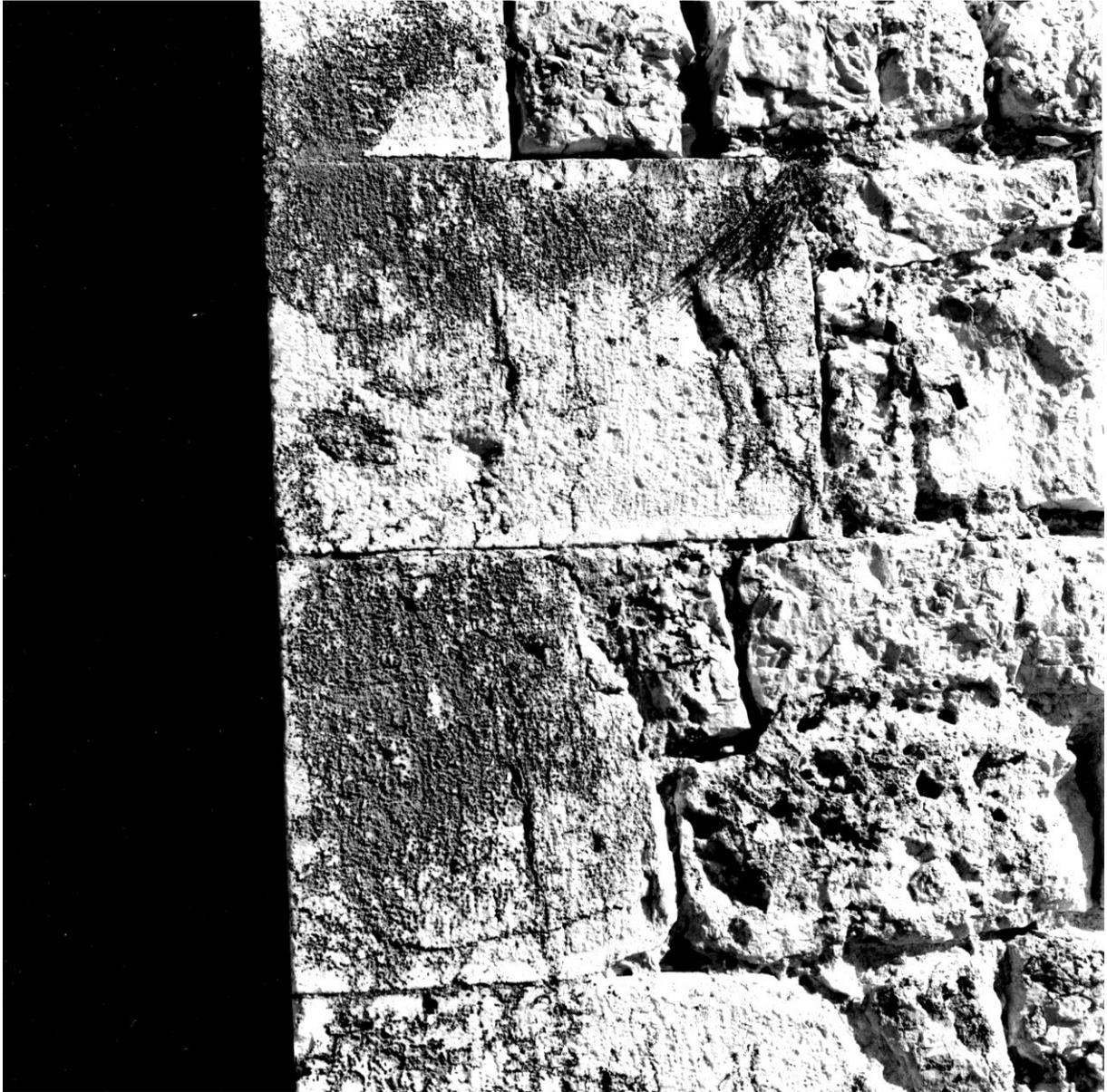
Fig. 74. La façade antérieure, la porte principale, détail : pierres de l'encadrement dressées à la gradine, vues depuis le sud
