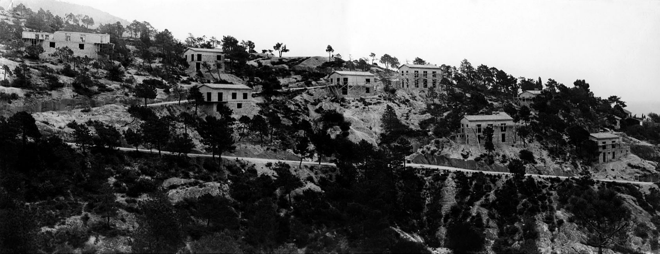
21.2 Le lotissement du domaine des pins à Menton en cours de construction, octobre 1947. photo Laboratoire départemental de l'Équipement. 598W 10
