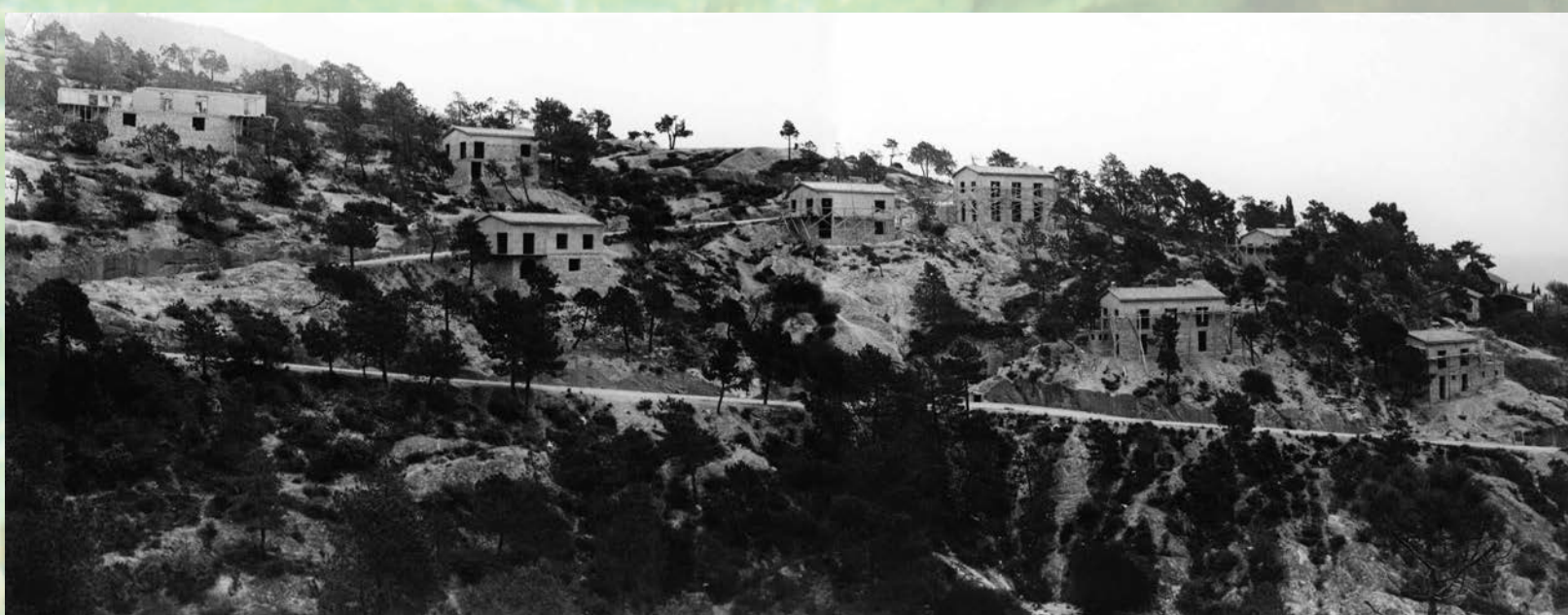
Le lotissement du domaine des pins à Menton en cours de construction, octobre 1947. Photographie Laboratoire départemental de l'Équipement. Arch. dép. Alpes-Maritimes, 598 W 10
