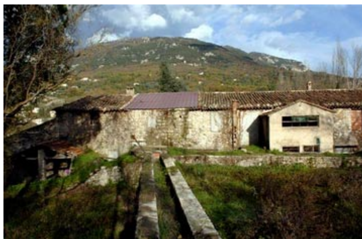
Canal d'arrivée d'eau au moulin
