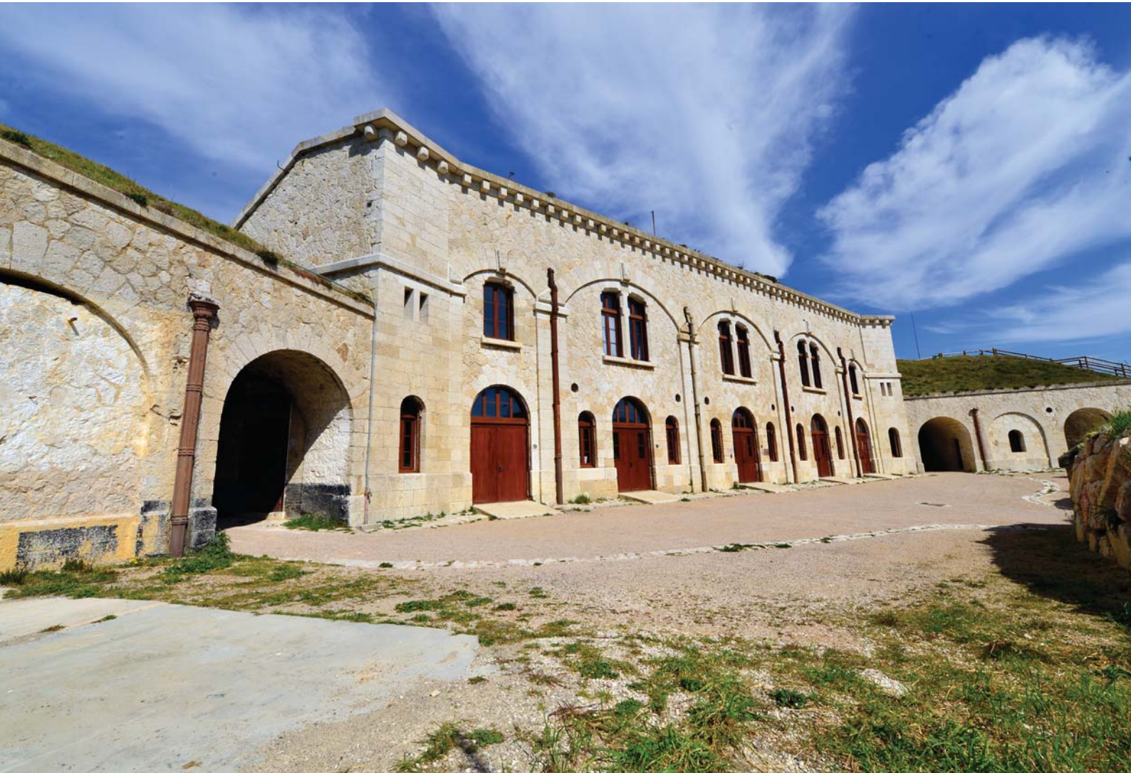
Cour centrale et casernement de la troupe, 2016
