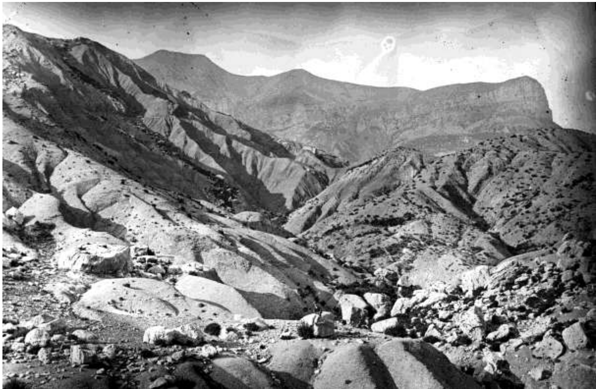
Bassin de réception, berges en éboulement dans les terres du torrent de Péroucie, affluent du Var à Villeneuve-d'Entraunes, 1 er août 1887. Photographie Eaux et Forêts, 23 Fi 43.
