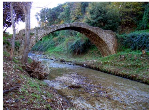
PONT SUR LA BRAGUE CONSTRUIT EN 1665
