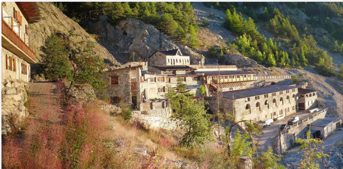
"Neige et Merveilles" : les bâtiments de la mine de Vallauria aujourd'hui
